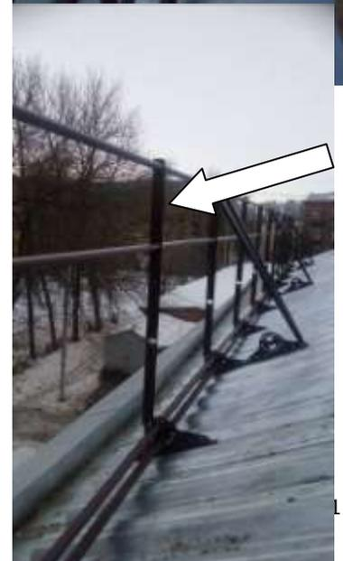
2. Бортовой элемент № 2 площадок представлен на рисунке В2., размером 140 мм, но при этом высота его расположения относительно площадки не задана. Какова максимальная высота расположения бортового элемента ?. Следует ли в данном случае выполнять размер  $h$ , и каково минимальное расстояние между элементами 4 и 3, 3 и 2.
