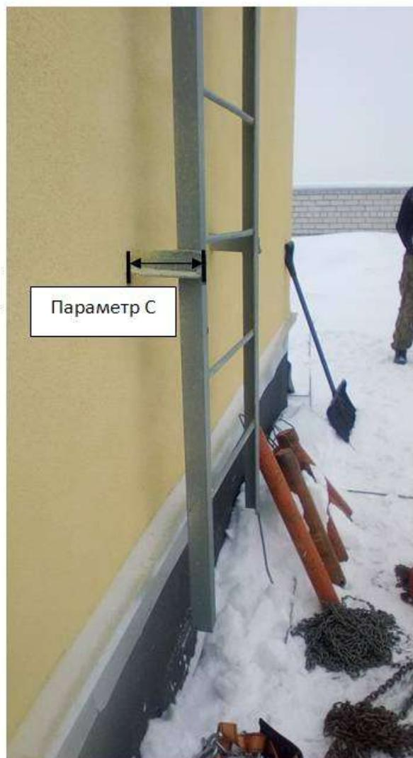
Ниже приведены параметры для расчета нагрузки, при условии выполнения лестниц по ГОСТ Р, нагрузка не превысит 100 кгс/
